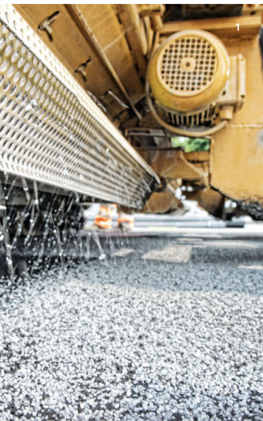
1 Gleichzeitiger Einbau von Abstreumaterial und Asphalt 2 Innovationsbunker
